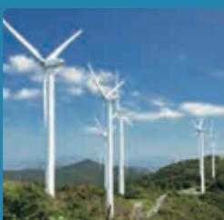
風のチカラで風車を回し、その回転運動を発電機に伝えて電気を起こします。陸上に設置されるものから海上に設置されるものまであります。
