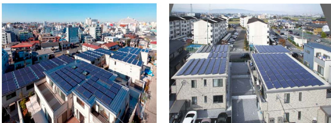
写真 4-3-1 集合住宅用太陽光発電設置事例
