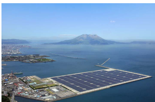
写真 2-6 特別高圧発電設備
