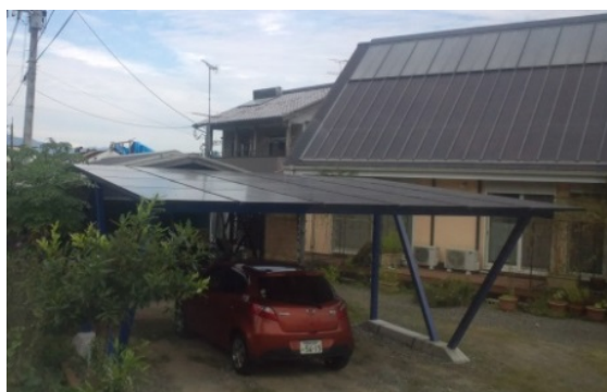
写真 2-2 屋根以外設置事例
