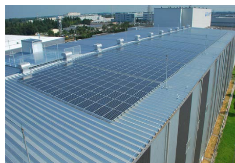
写真 2-5 高圧案件 折板屋根設
