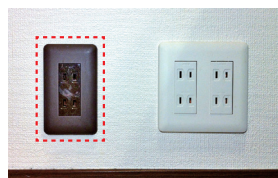
非常用コンセント (屋外設置パワーコンディショナの例) ※左側が非常用コンセントになります。
