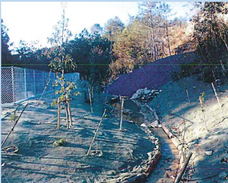
ビオトープ及び水路の設置
