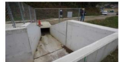
用水路の整備
