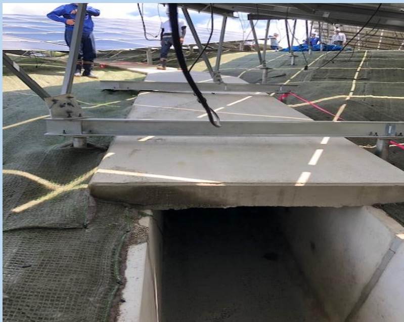
屈曲部排水路への蓋の設置
