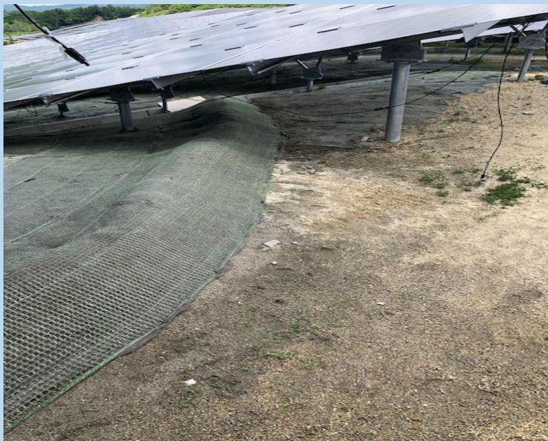
小堰堤による排水路までの導水路
