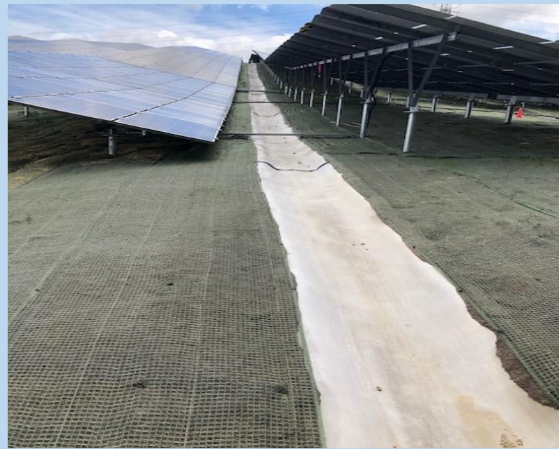
追加排水路の設置 多機能フィルターの設置
