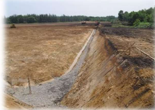
処理後(暗渠管設置)
