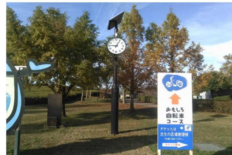
公園内に設置された太陽電池式街灯・時計台
