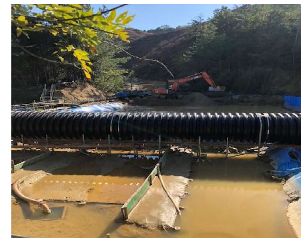
清水・濁水を分離した排水路を設置
