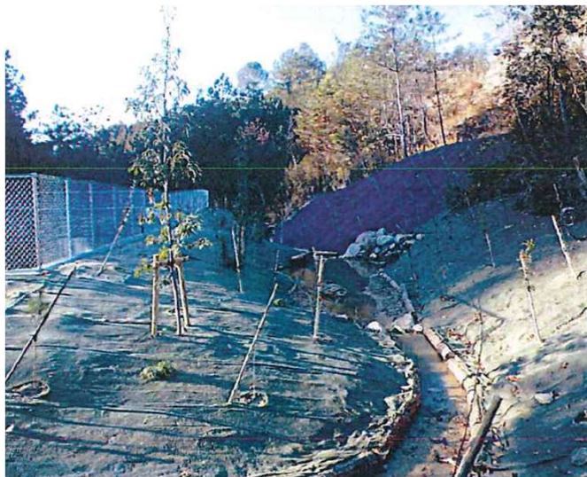
ビオトープ及び水路の設置
