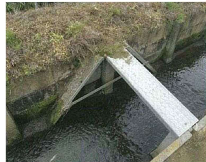
小動物移動機能付き水路の設置
