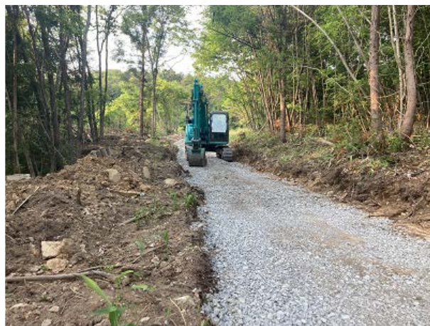
発電所進入路の整備も 大切な仕事
