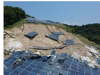
擁壁の破損に伴う斜面崩壊の例
