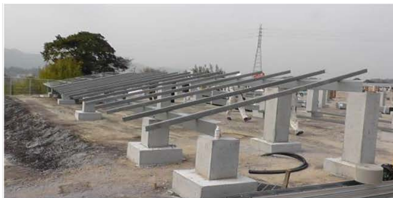
直接基礎（独立基礎）の例
