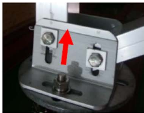
長孔を用いた接合（柱脚）
