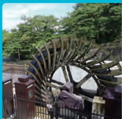
水力発電は河川などの高低差を活用して水を落させ、その際のエネルギーで水車を回して発電します。現在では農業用水路や上水道施設などでも発電できる中小規模のタイプが利用されています。
