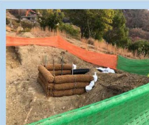
沈砂池とバイオフィルターの設置
