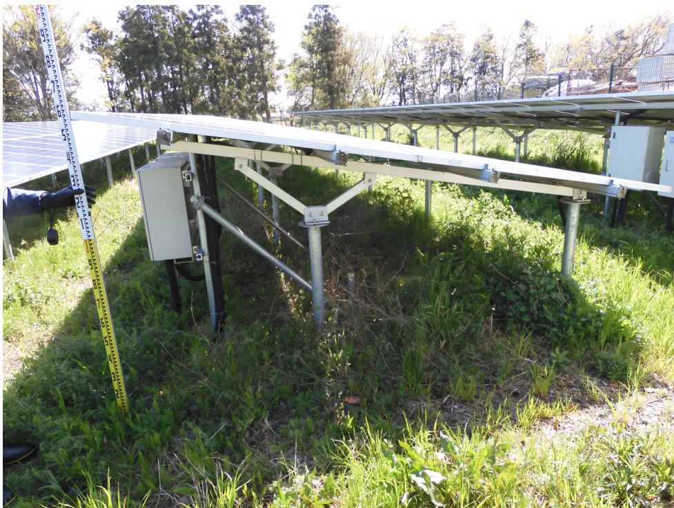
写真3.2.1 支持物の最高高さ 測定例
