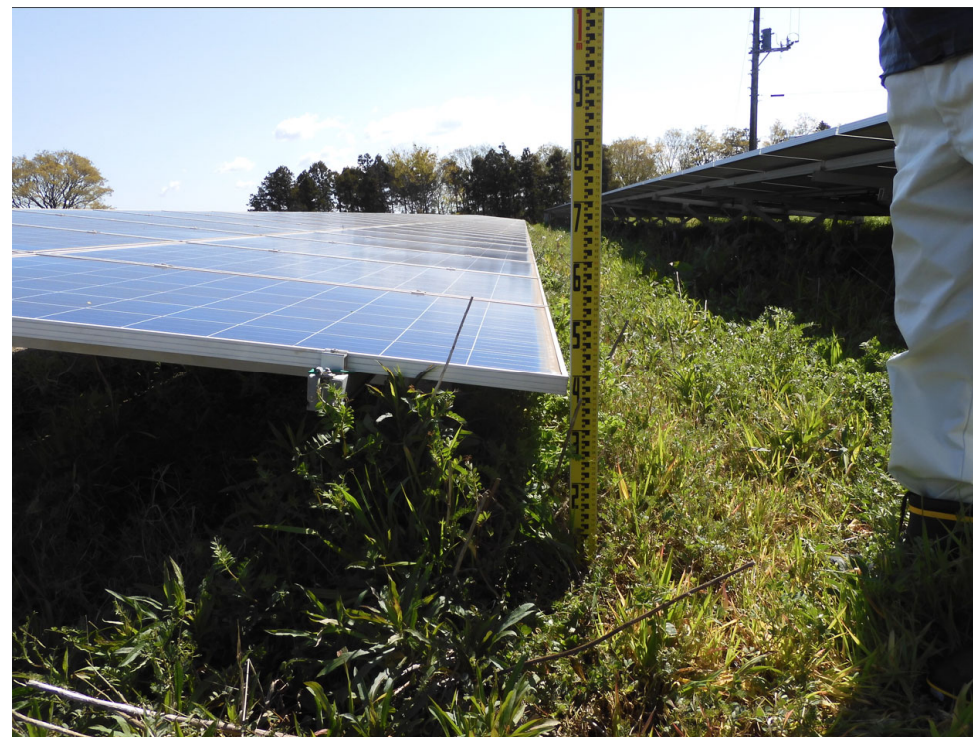
写真3.2.2 支持物の最低高さ 測定例
