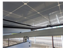
※BPD 破損確認のため端子箱のフタを外している。
