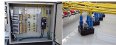
右側、最下段 BLD 逆接続
