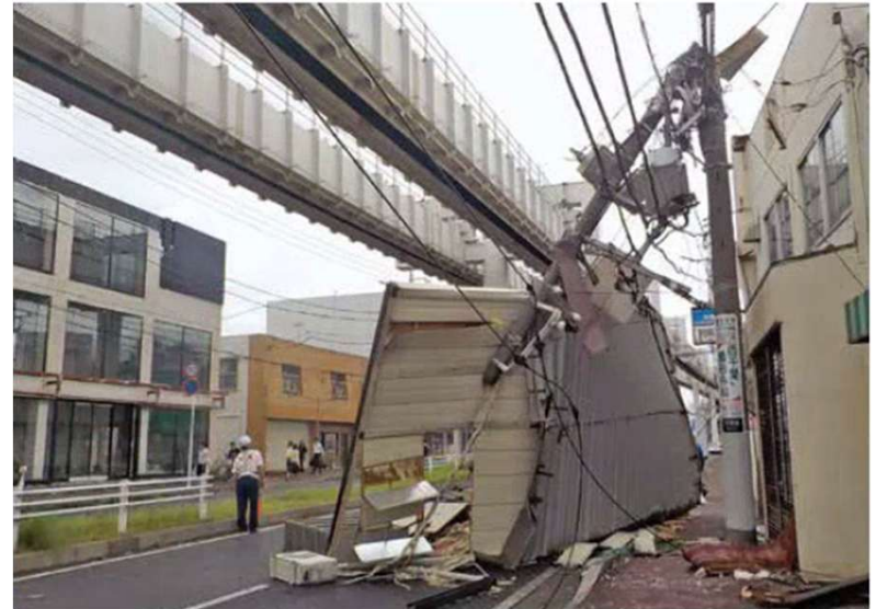
道路上に倒壊したプレハブ
