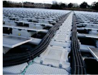
写真12-2 配管に納めた 配線の例
