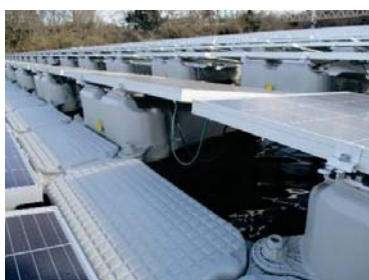
写真12-1 余長を考慮した 配線の例
