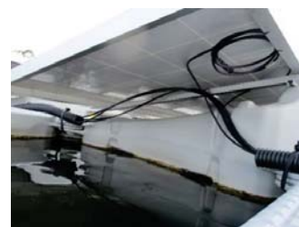
写真12-2 配管に納めた 配線の例
