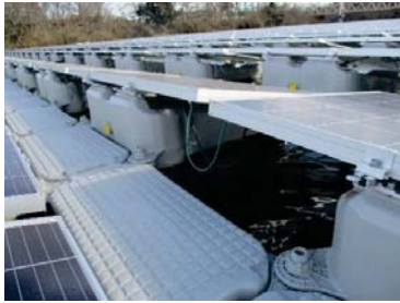
写真12-1 余長を考慮した 配線の例
