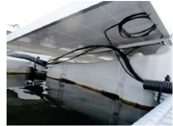
写真12-2 配管に納めた 配線の例
