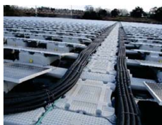
写真12-2 配管に納めた 配線の例
