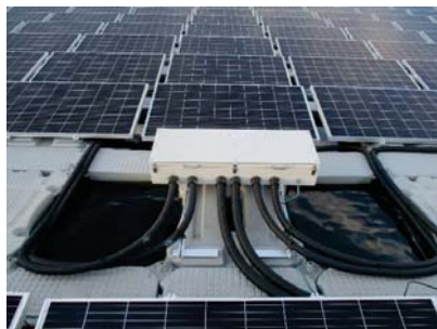
写真12-3 接続箱の設置例
