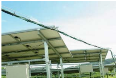
写真12-2 架空配線の例
