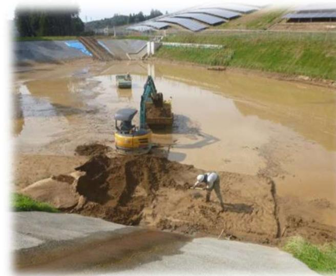
盛土・切土造成土量の削減：既存の起伏を活かした造成計画、建設中の裸地状態を減少
