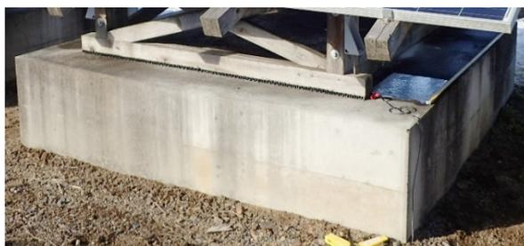
図 3-10 太陽光発電設備のコンクリートの置き基礎
