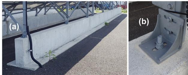
図 3-9 根入れコンクリート基礎とコンクリート基礎と金属鋼材の接合部
