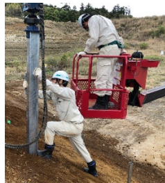
(b) 型鋼杭の施行令例（打撃貫入）
