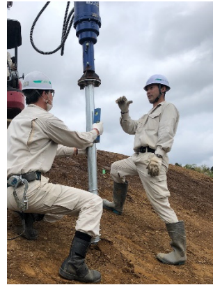
(a) スクリュー杭の施工例（回転貫入）
