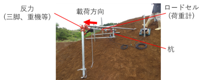
(c) 水平載荷試験の状況
