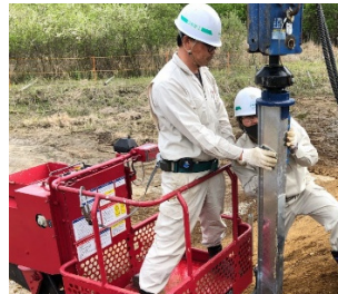
(b) 型鋼杭の施行令例（打撃貫入）
