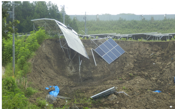
写真 2-4 傾斜地設置型太陽光発電設備の豪雨被害事例（4）写真提供：一般市民
