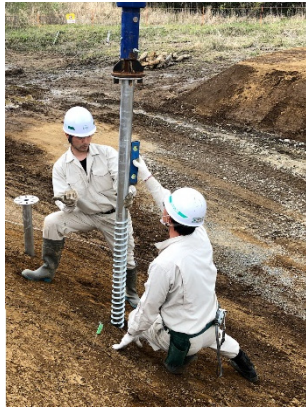
(a) スクリュー杭の施工例（回転貫入）
