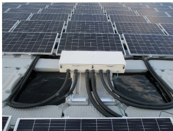
写真 12-3 接続箱の設置例
