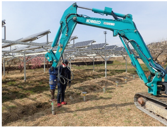
図 4-1 農地での杭の打設風景
