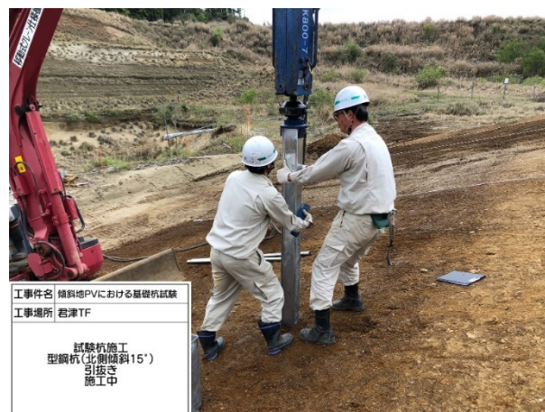
図 4-1 傾斜角度 15 度重機による施工風景（形鋼杭）
