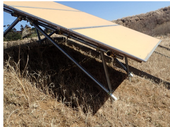
図 5-6 30 度植生工 架台（長辺傾き 3 度）
