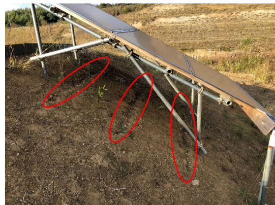
図 5-8 水路付き架台（左：15 度傾斜、右：30 度傾斜）
