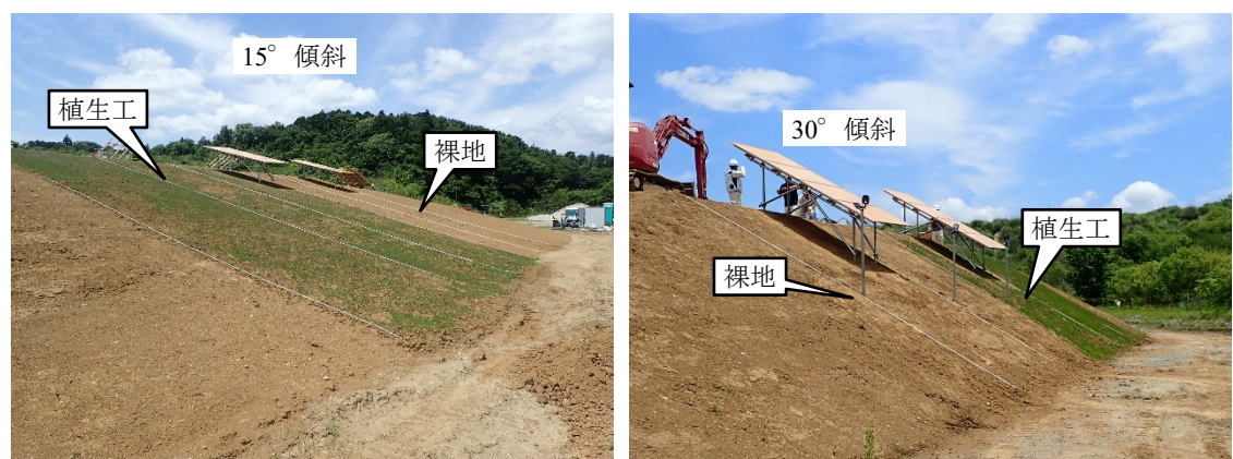
図 4-2 検証対象の傾斜地状況
