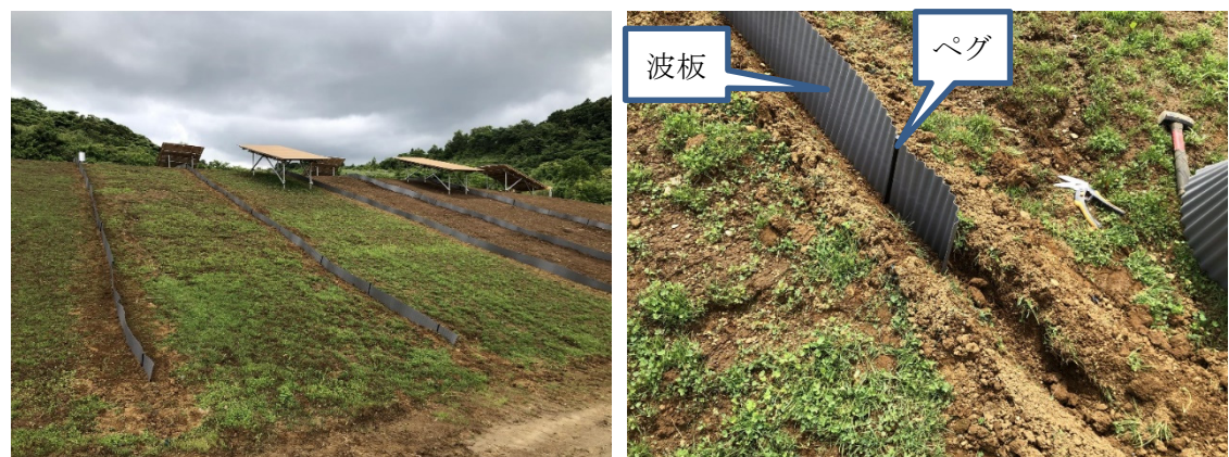
図 4-3 セパレータの設置状況
