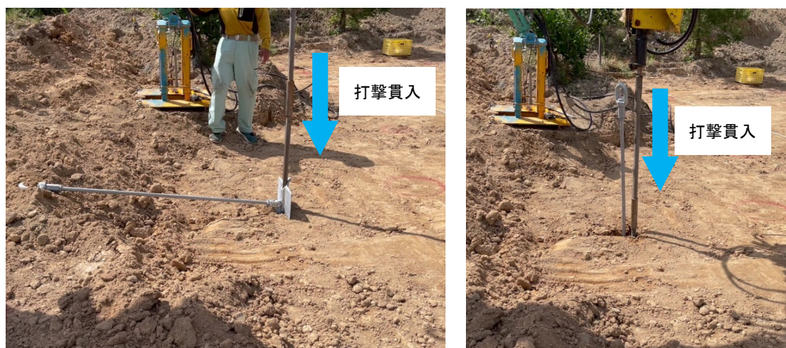
図 3-2 アンカー貫入状況（左：貫入前、右：貫入途中）
