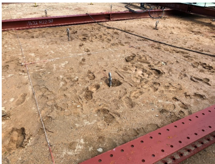
図 3-5 試験地盤（試験前）
