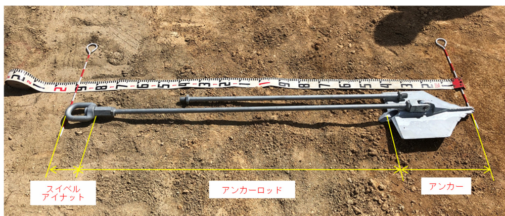
図 3-1 アンカー全景
