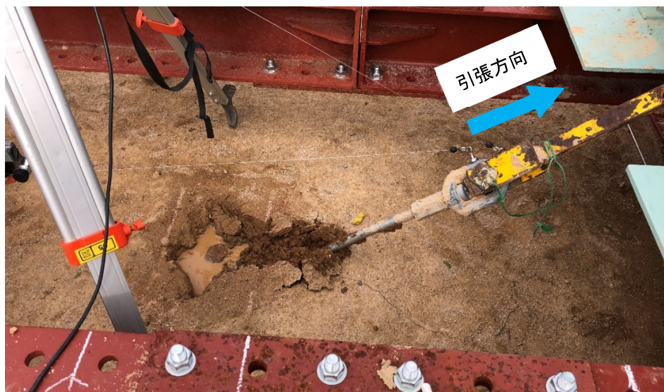
図 2-2 斜め引張試験状況（試験後）
