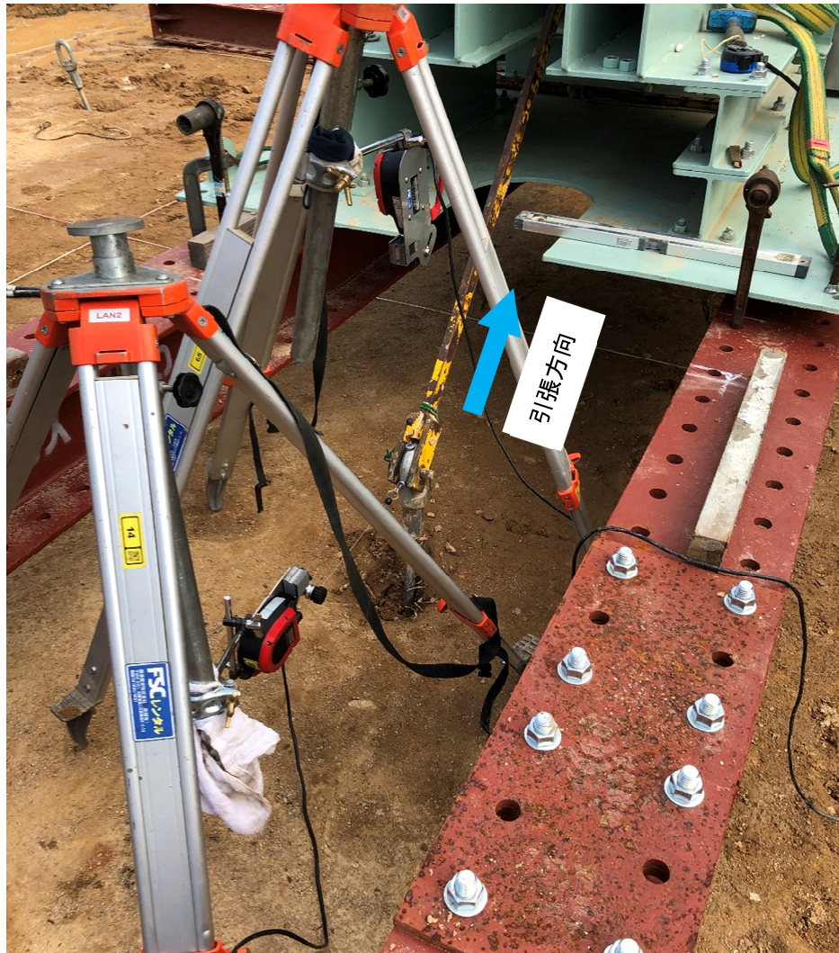
図 2-1 斜め引張試験状況（試験前）
