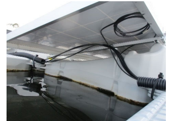
写真12-2 配管に納めた配線の例
