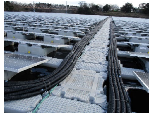
写真12-2 配管に納めた配線の例
