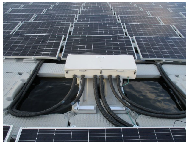
写真12-3 接続箱の設置例
