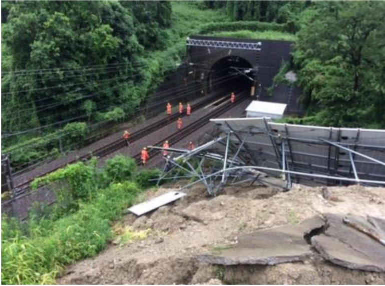
神戸市の斜面崩落
