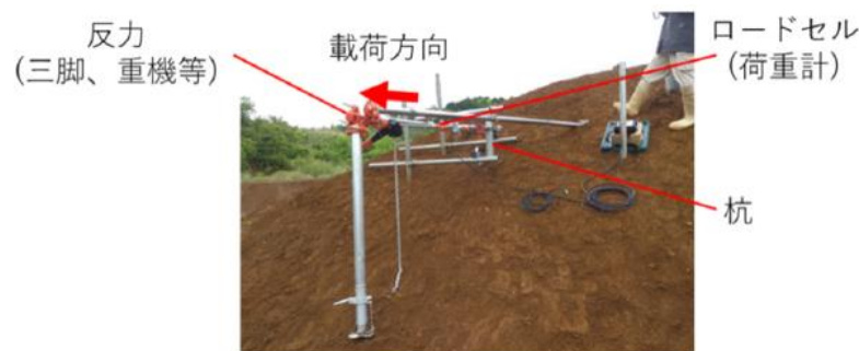
(c) 水平載荷試験の状況
