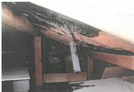
写真 2-7 住宅に設置された太陽光発電設備の火災事例
