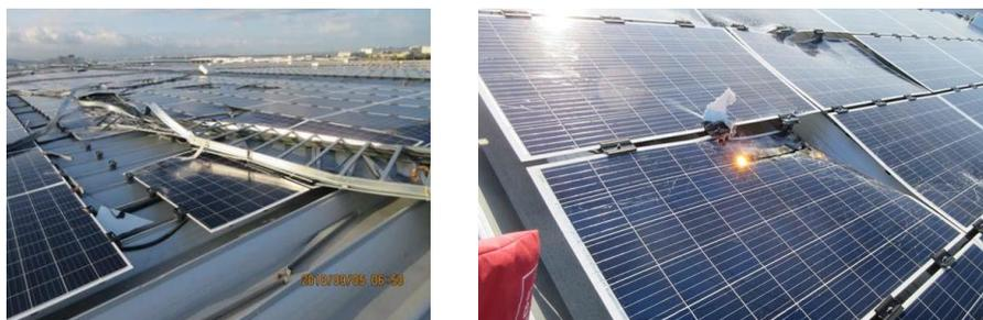
写真 2-2 折板屋根に設置された太陽光発電設備の強風被害事例
