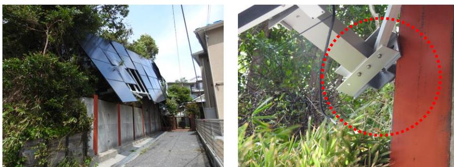
写真 2-1 陸屋根に設置された太陽光発電設備の強風被害事例
