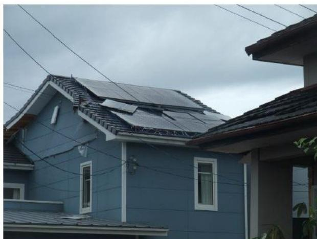
写真 2-4 住宅に設置された太陽光発電設備の地震被害事例
