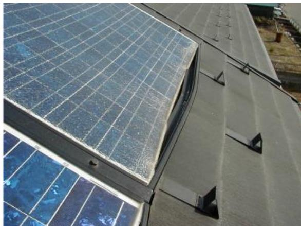
写真 2-3 住宅に設置された太陽光発電設備の地震被害事例
