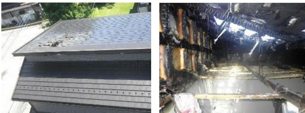
写真 2-6 住宅に設置された太陽光発電設備の火災事例
