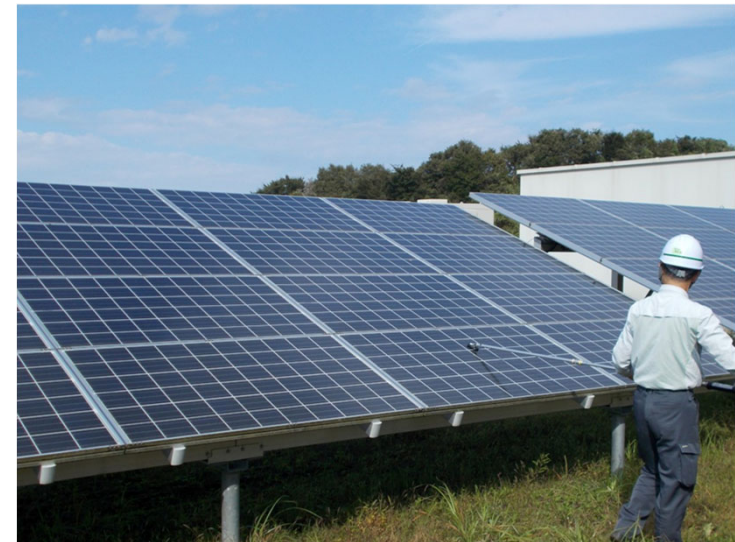
図 非接触電流測定によるストリング配線の確認方法の概要
