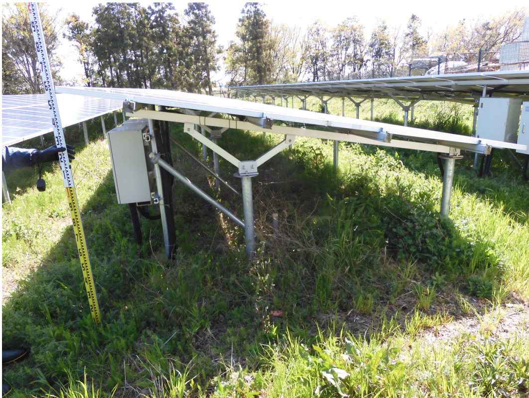
写真3.2.1 支持物の最高高さ 測定例
