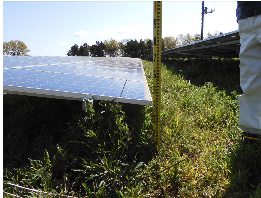
写真3.2.2 支持物の最低高さ 測定例
