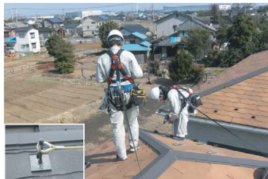
親綱と安全帯による対策 (親綱支柱の設置場所の確保必要)
