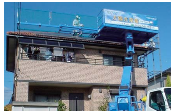
高所作業車による対策 (作業車駐車スペースの確保が必要)
