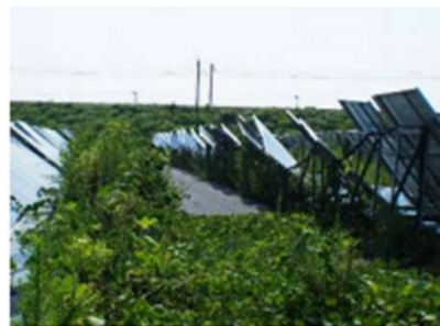
不十分な管理で放置されたパネル
