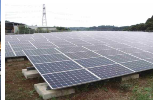
廃棄物処分場
