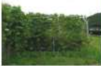
草木の成長によるフェンスの 倒壊事例-1
