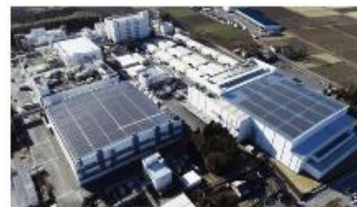
図1 栃木工場の太陽光発電設備（工場の屋上の様子）
