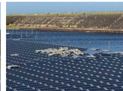
例：水上型における破損
