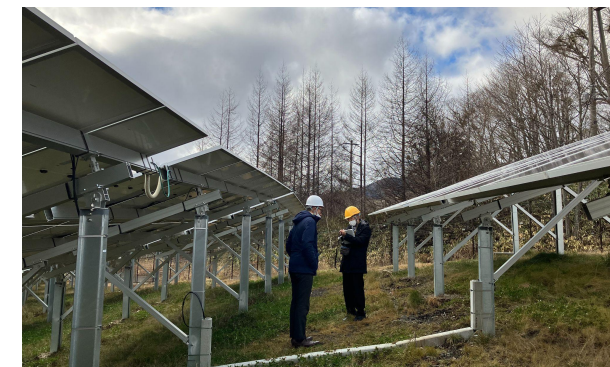
架台の高さは約1.5mとし雪が滑り落ちる余地を作った
