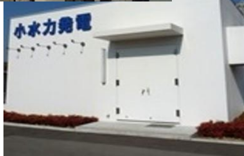
上水道の小水力発電
