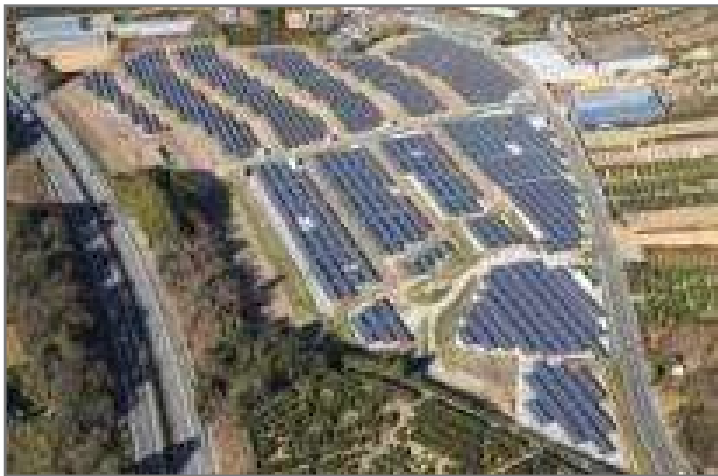
浜松・浜名湖太陽光発電所 (静ヶ谷最終処分場)
