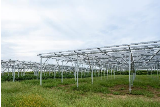
農業者の声に応じて開発した最新架台。従来型より 20cm 高く、筋交いの角度も改良されているので、大型の農業機械を安心して動かすことができる（左は従来型）。
