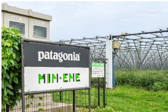
市民エネルギーちばが初めて手掛けたオフサイト PPA 案件。需要家である「パタゴニア」は、定期的な草刈り体験など社員教育の場としても活用している。
