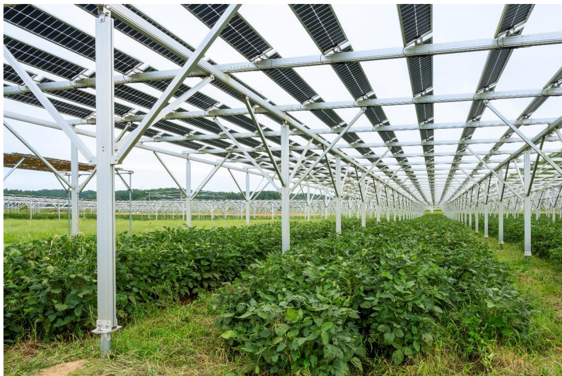
匠瑤メガソーラーシェアリング第二発電所（2.7MW）。ソーラーシェアリングに最適な細型（2列セル）のパネルの下で、大豆が健やかに育っている。
