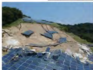
土砂崩れで生じた崩落
