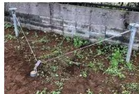
図Ⅲ-2-(ロ)-(i)-D-1 杭補強の施工事例
