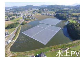
三井住友建設HPより
