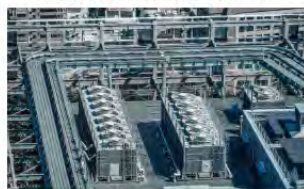
冷却塔・給水塔の設置イメージ
