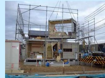
ユニット工法を採用、工業化の徹底により環境負荷の小さな住宅システム構築を目指している
