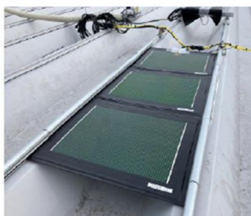
折板屋根への設置例
