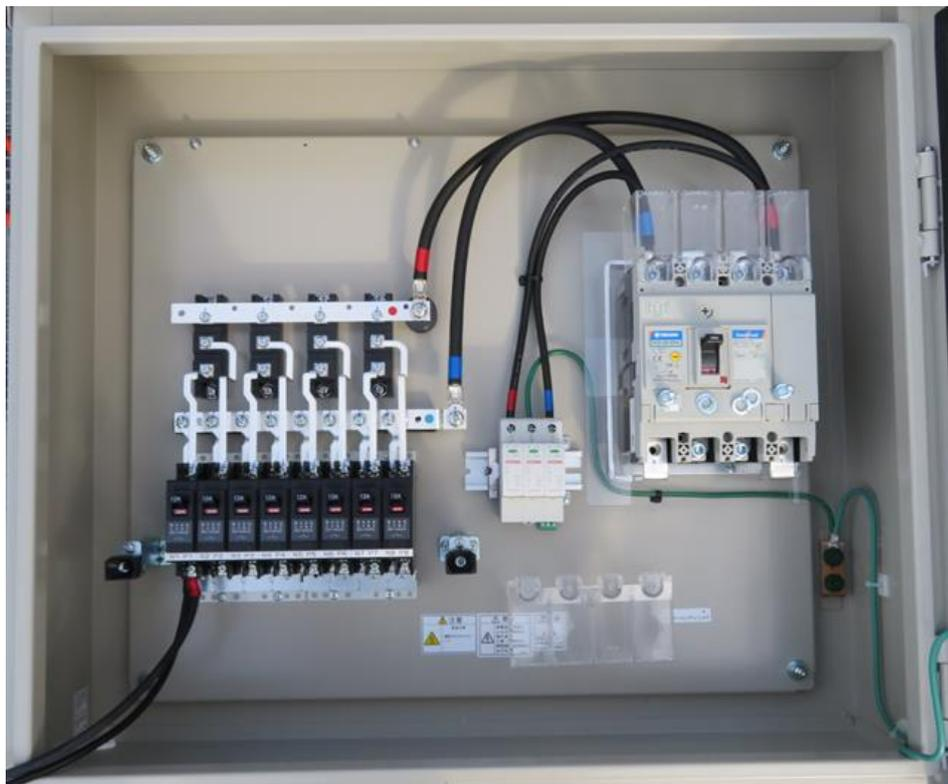
図 6-18 ダイオード方式の接続箱内部
