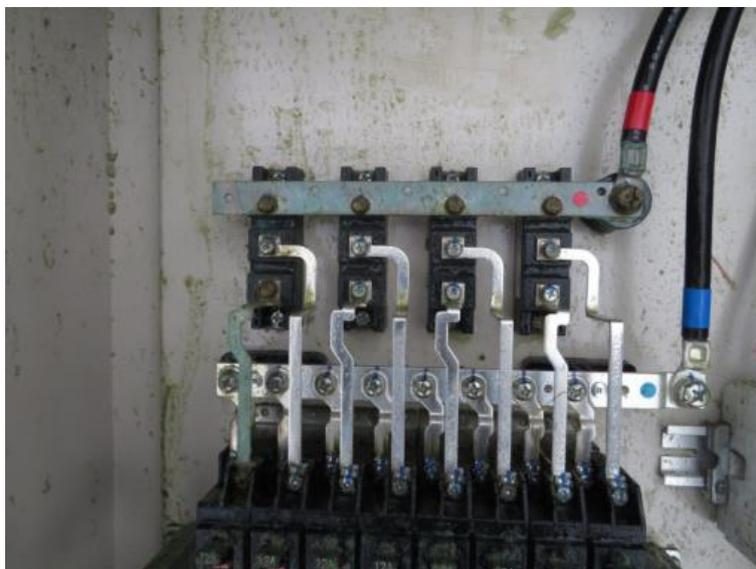
図 8-2 水没後の腐食
