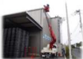
場合によっては高所作業車で屋根上点検実施
