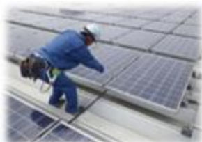
太陽電池外観点検
