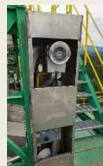
凍結対策を実施したドラムレベル計、ボイラ薬品ライン
