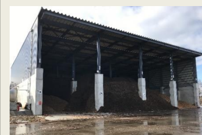
燃料の凍結防止のため、増設した保管庫と廃熱利用の場内融雪装置
