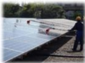
太陽電池清掃作業
