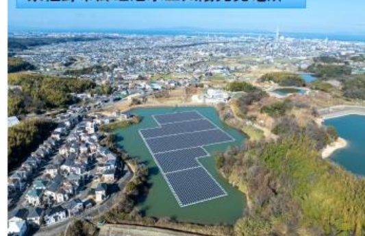
泉佐野市郷之池水上太陽光発電所
